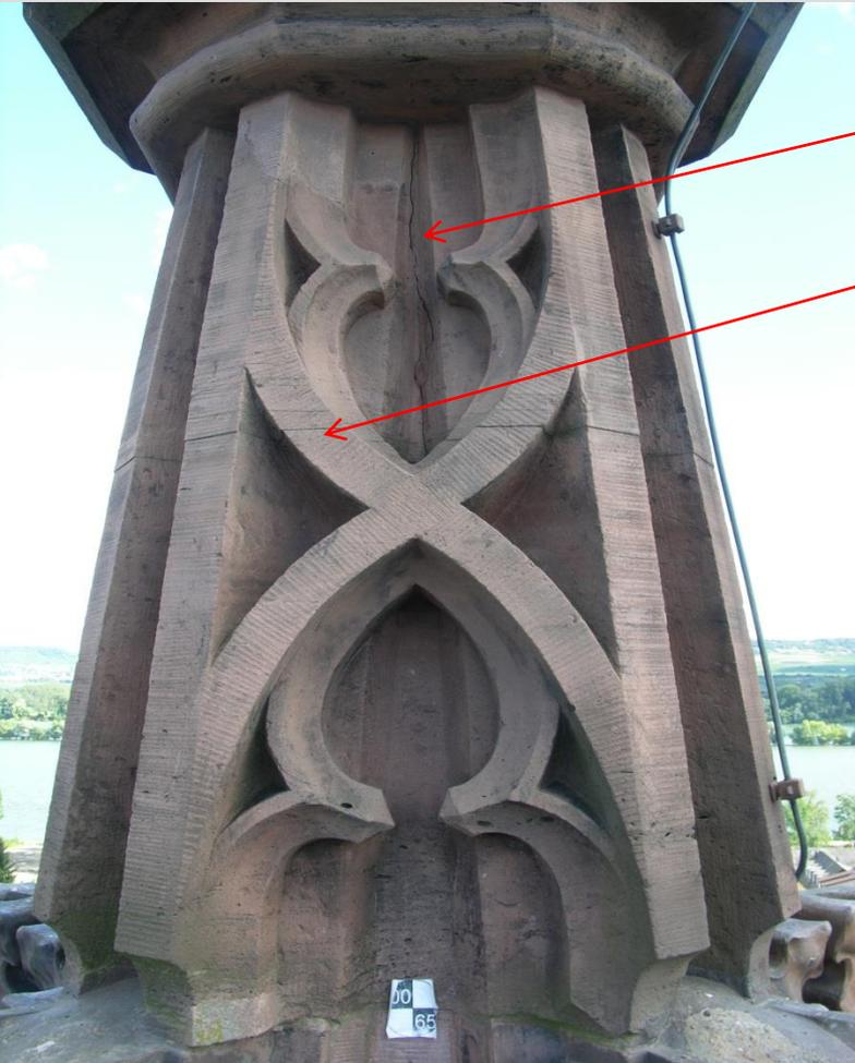
Rissbildung infolge Korosion von Stahlteilen (Sprengschaden)
