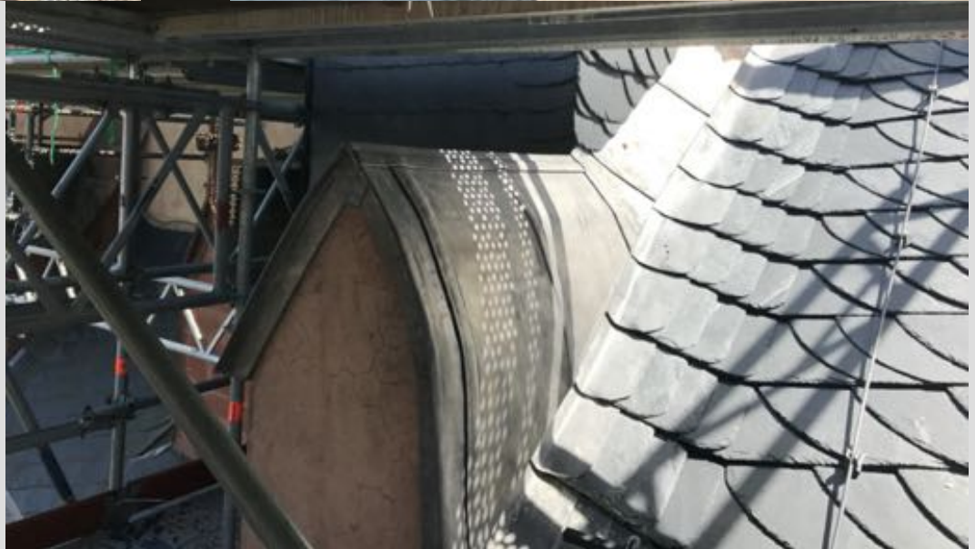
Fertiggestellte Verdachung der Schildwände Chor- Kirchenschiff
