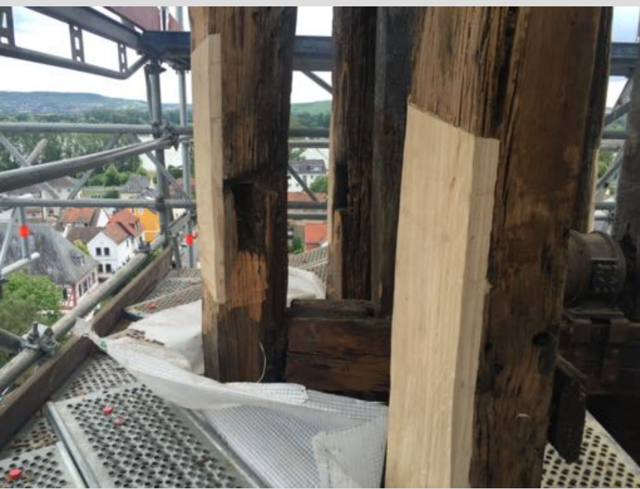
Instandsetzung Dachreiter, Bereich Laterne
